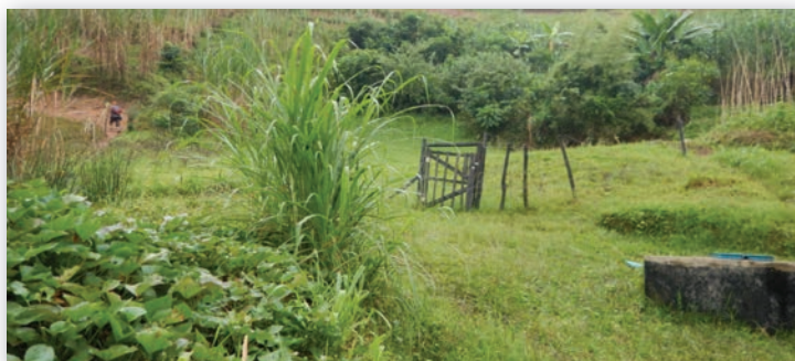
De bron Nyamaraba: opvang water via draineerbuizen – gelegen op 1945 m (Thommen) - matig debiet 0.5 l/sec - troebel water - drassige omgeving wat doet vermoeden dat draineerbuizen verstopt zijn en slechts een deel van het totale debiet van de bron opvangen.
